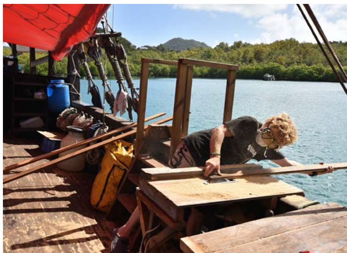
Na Viktorce. Příprava latí pro opravu záďového kastelu.
