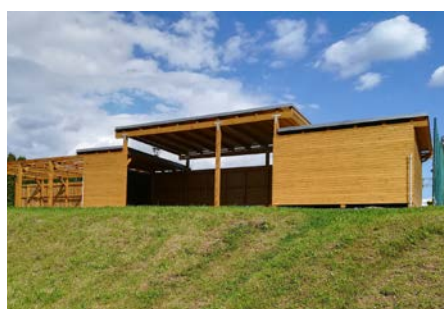
Realizace projektu venkovní třídy ZŠ a MŠ Štěpánkovice
