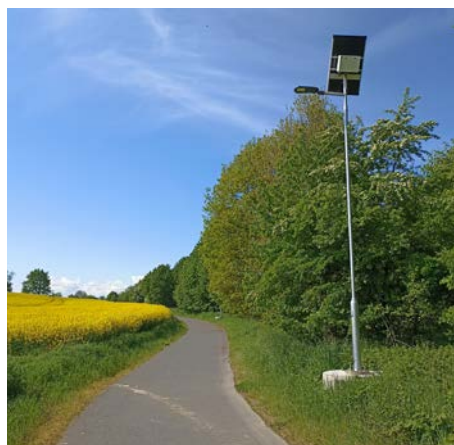
Solární světla zvýší bezpečnost na cyklostezce ...více na straně 7
