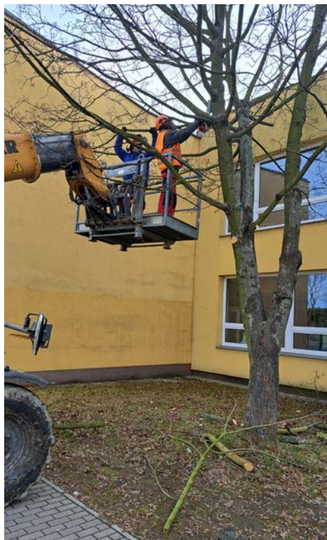
Bezpečnostní ořez stromů v areálu školy
