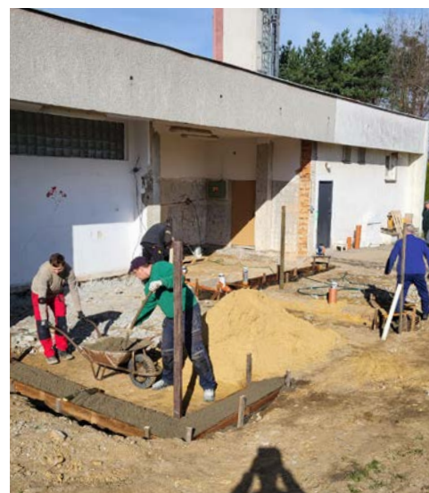
Začátek rekonstrukce zahrádkářského areálu
