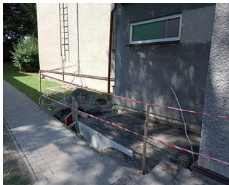
Přístavba místnosti pro bankomat
