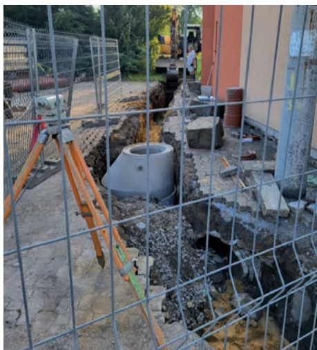
Rekonstrukce kanalizace Zahradní - Lipová
