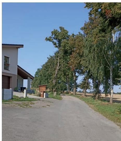
Rekonstrukce polní cesty Svoboda – Chlebičov ...více na straně 2
